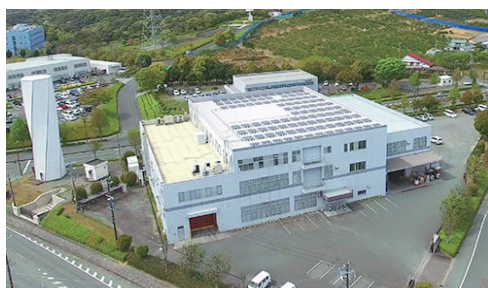
新都田工場 発電設備出力49.5kW 面積1,000㎡
